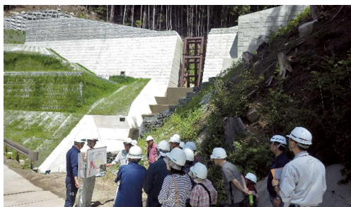
【住民完成見学会状況】
