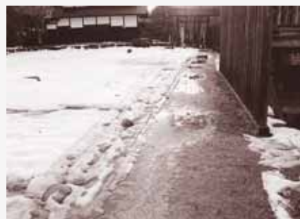
中山道部分の未舗装箇所のぬかるみ
