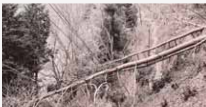
送電線への倒木の様子
