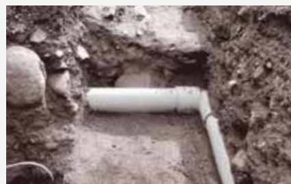
配水管の残存状況
