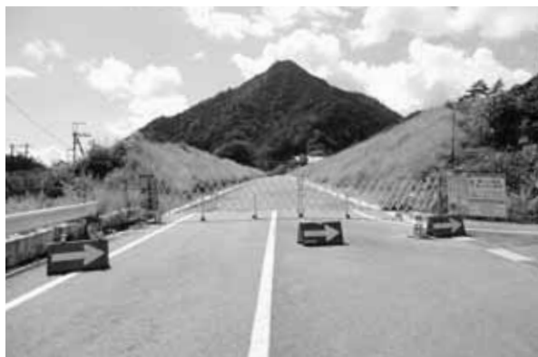
右岸道路 “工事中”
