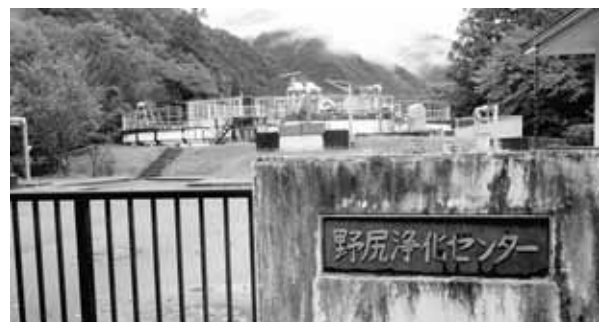
野尻浄化センター
