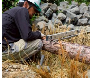
藁を敷きレベルを見て
