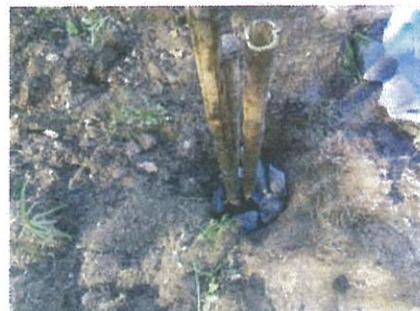
水を浸透させる縦に掘った穴
