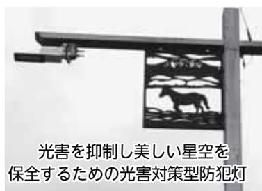
光害を抑制し美しい星空を保全するための光害対策型防犯灯
