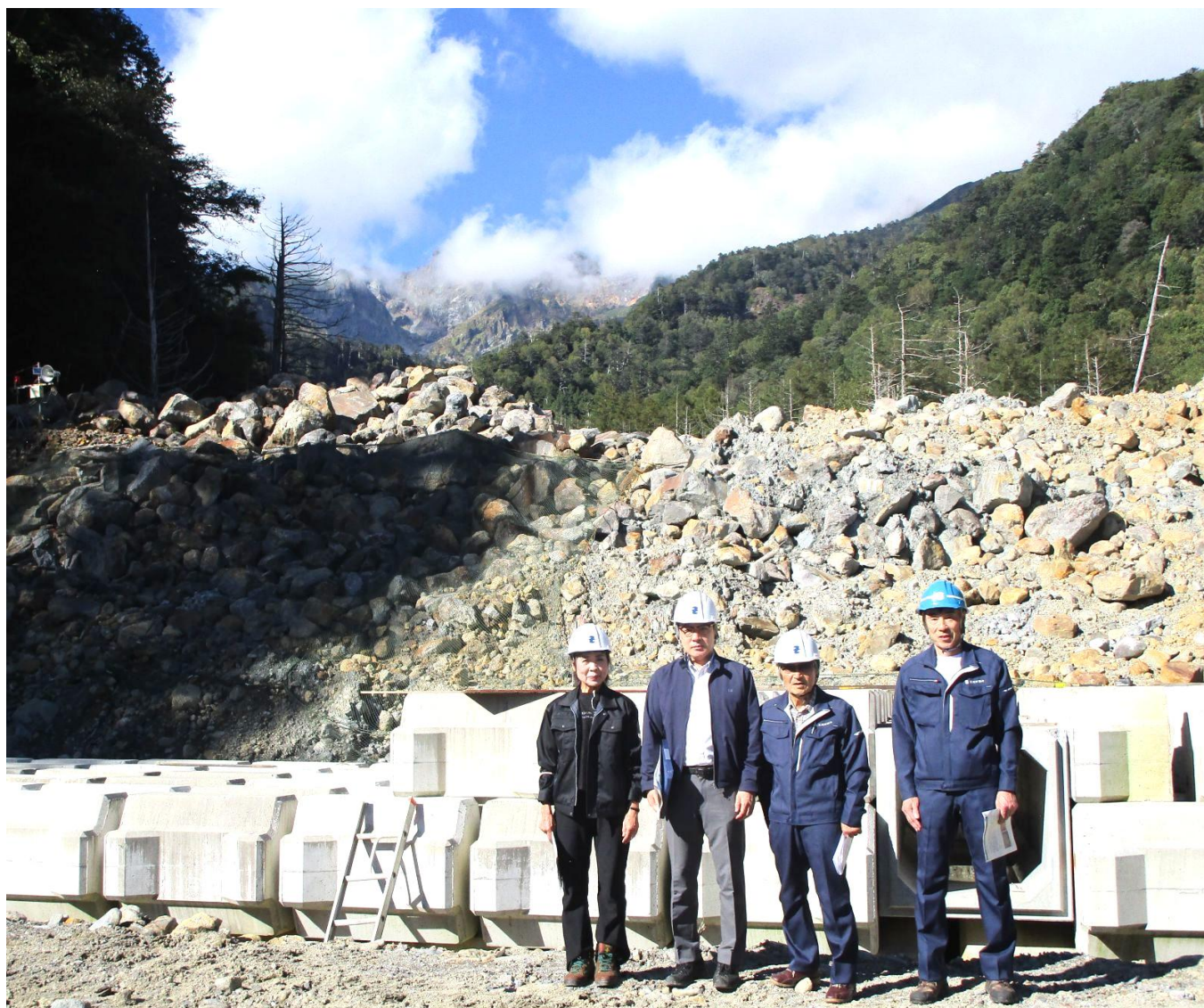
御岳国有林 濁川復旧治山工事現場を視察
