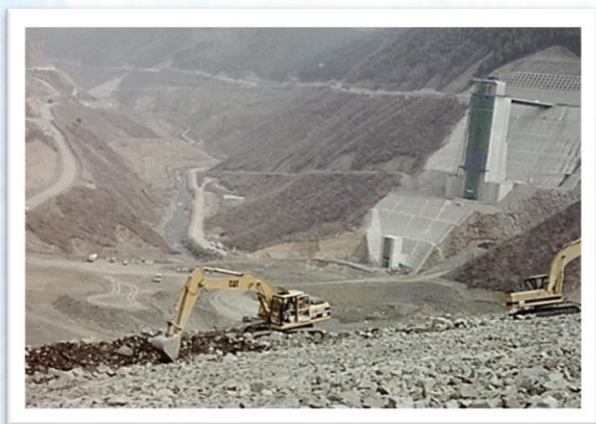
建設当時を「取水塔」で比較
