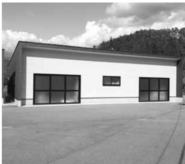
役場防災倉庫棟
