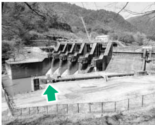
大桑野尻発電所（小水力）
