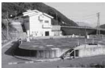
木曽福島浄化センター
