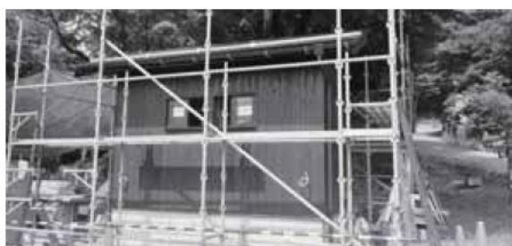
かぶと観音のトイレ工事
