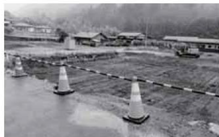
旧田立電機解体跡地
